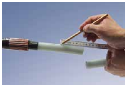
Préparation du câble
