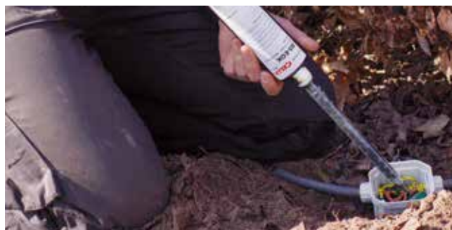
Snel en eenvoudig afvullen met het AMX giethars injectiesysteem.
